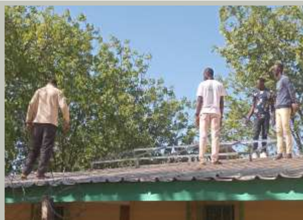
Installation des panneaux solaires sur le toit
