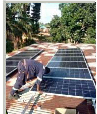
Installation sur le toit de panneaux solaires pour les bureaux de la Paroisse
