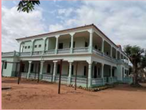
Rénovation du lycée de l'Institut de l'agriculture à Magude, au Mozambique
