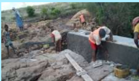
Construction de puits et d'un barrage pour l'eau potable et la résilience agricole à Madagascar
