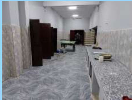
Rénovation de la cuisine du séminaire d'Enugu, au Nigeria
