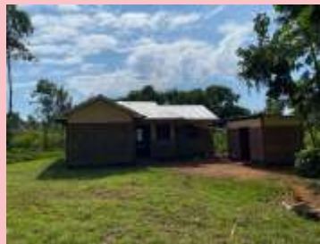
Construction de 5 maisons pour des familles vulnérables au Kenya
